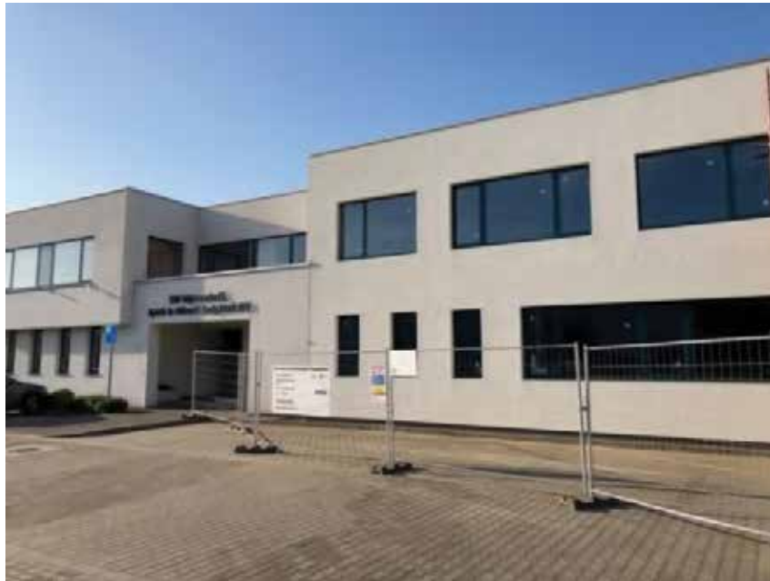
2. ábra A CHH győri székházához kapcsolódik a biotechnológiai méréseket és elemzéseket végző labor egy új épületszárnyban
